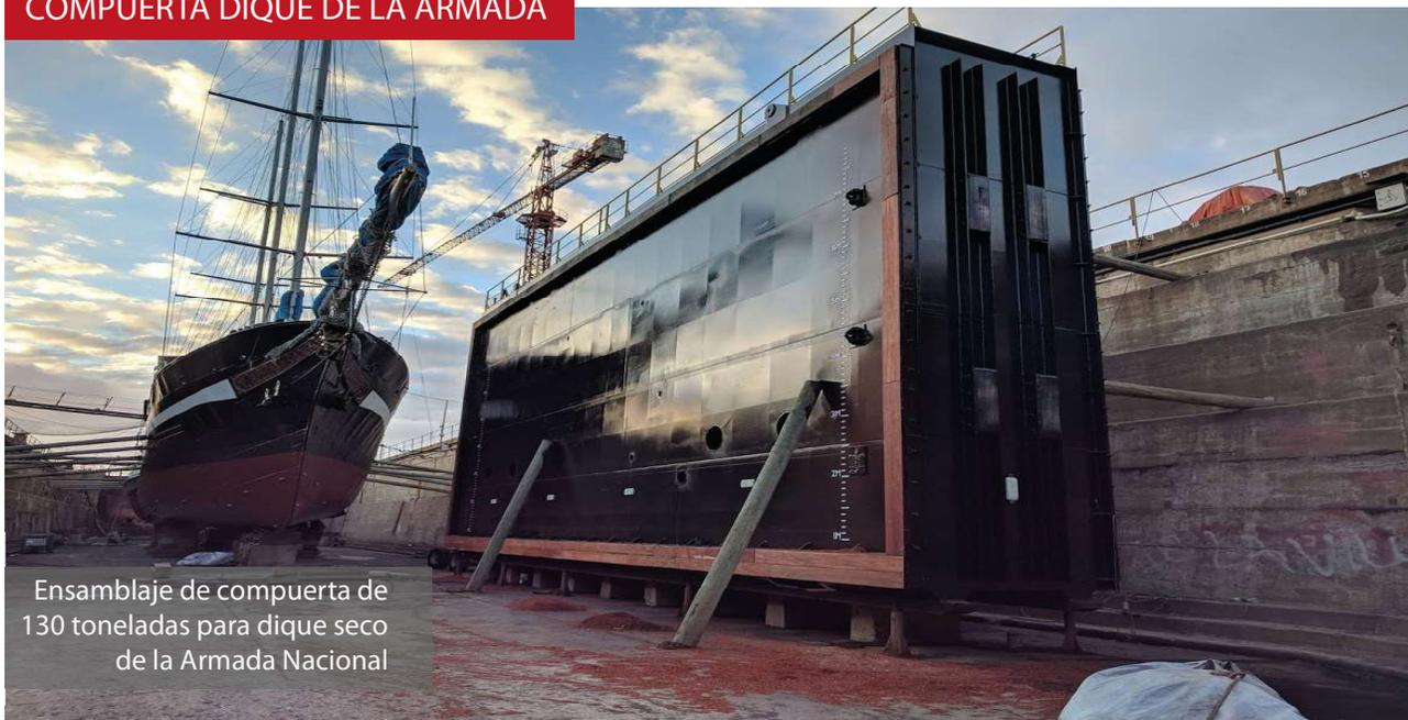
Ensamblaje de compuerta de 130 toneladas para dique seco de la Armada Nacional
